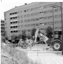
Desaparece la placa de hormigón del bidegorri de Zabalgana
