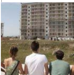
La constructora de VPO de Arkaiate espera comenzar las obras a lo largo de este mes
